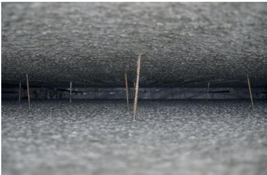
Die patentierte Rappertorfer Korbwand® vor dem Ausbetonieren. Mit bedeutend weniger Stahlverbindungen als bei herkömmlichen Doppelwänden wird eine sehr hohe Stabilität bei wesentlich geringerem Materialbedarf erzielt.
